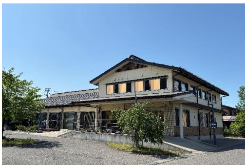
鉄骨造合金メッキ鋼板葺 2 階建
