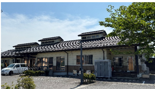
木造合金メッキ鋼板葺平家建
